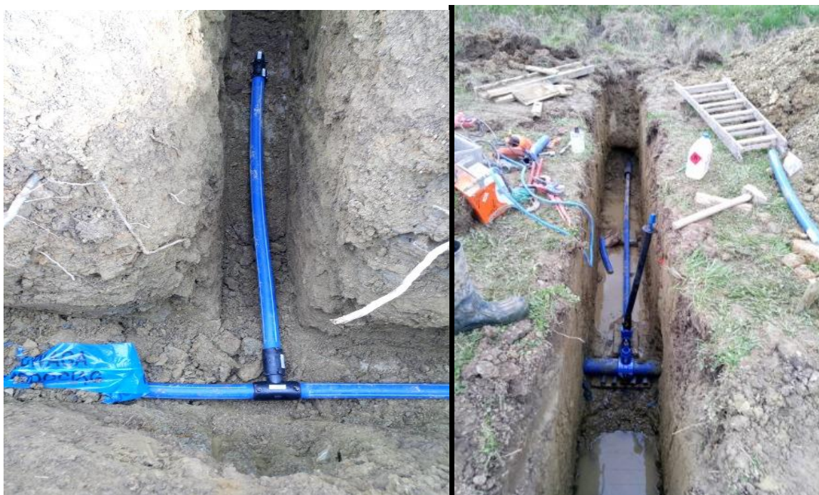
Zdjęcie nr 1 „Rozbudowa odcinka sieci wodociągowej w miejscowości Mokra Wieś w systemie zaprojektuj – wybuduj”.
