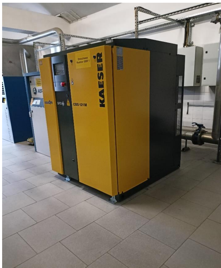
Zdjęcie nr 3 „Modernizacja systemu napowietrzania na oczyszczalni ścieków w Podrzeczu”.
