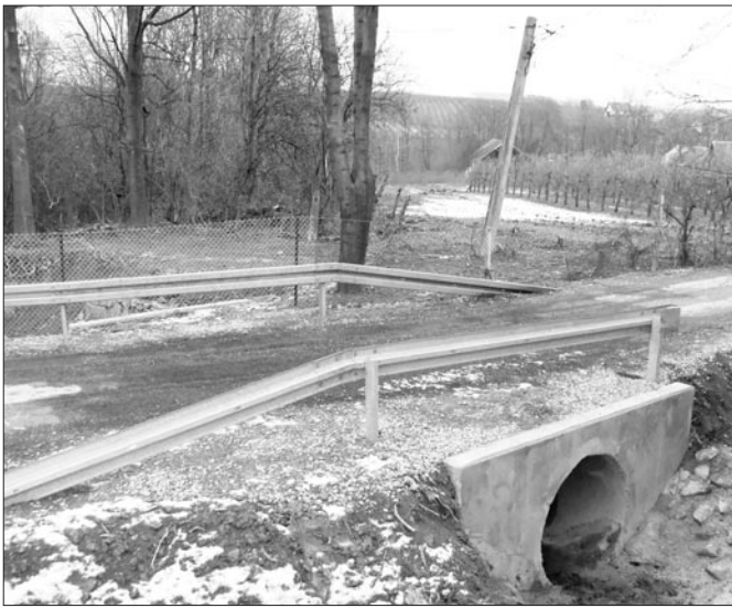
Olszana. Prefabrykaty – przekazano 47 przepustów
