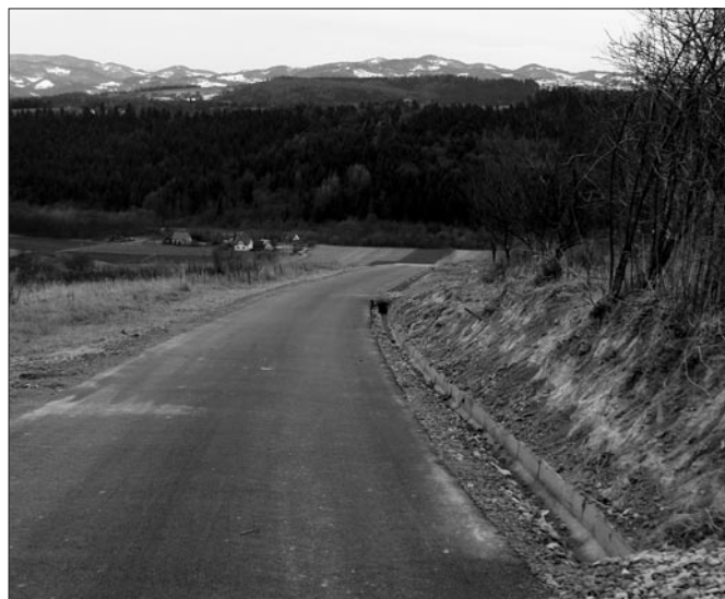
Rogi. Remont drogi „Poszczyny”
