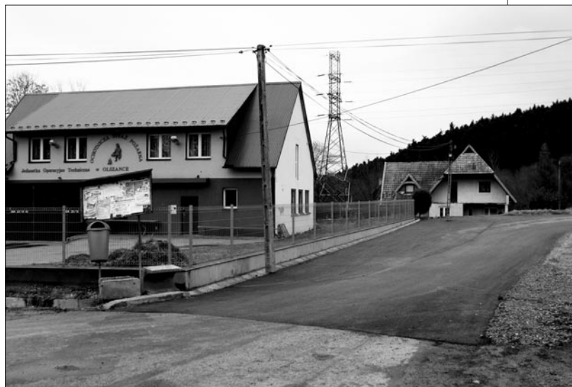
Olszanka. Remont placu w pobliżu remizy i drogi gminnej Dział
