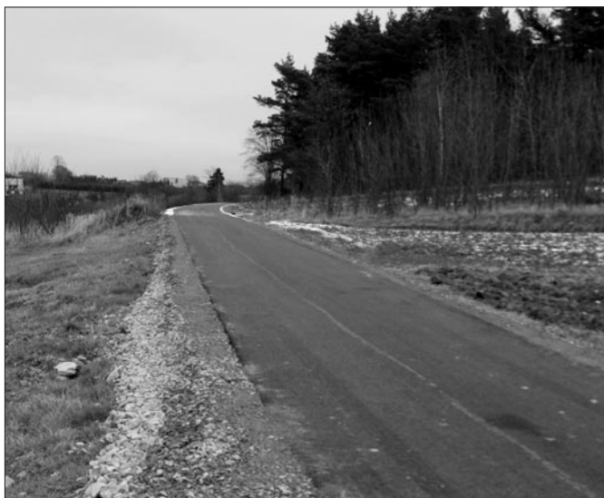
Mokra Wieś. Remont drogi gminnej Krzyże w stronę Owieczki
