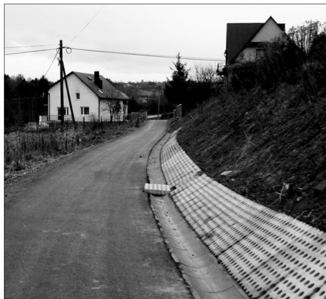
Poderodzie. Remont drogi wraz z odwodnieniem koło p. Franciszka Kosa
