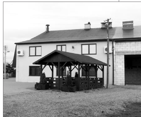
Przebudowa budynku OSP w Stadłach
