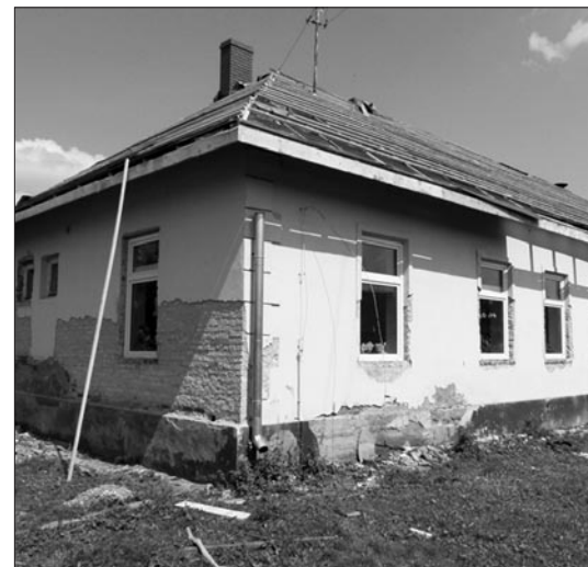
Remont GOK w Naszacowicach
