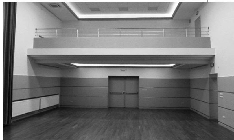
Remont pomieszczeń Gminnego Ośrodka Kultury w Podegrodziu
