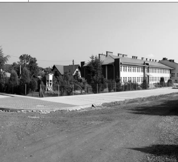
Przebudowa centrum wsi Brzezna
