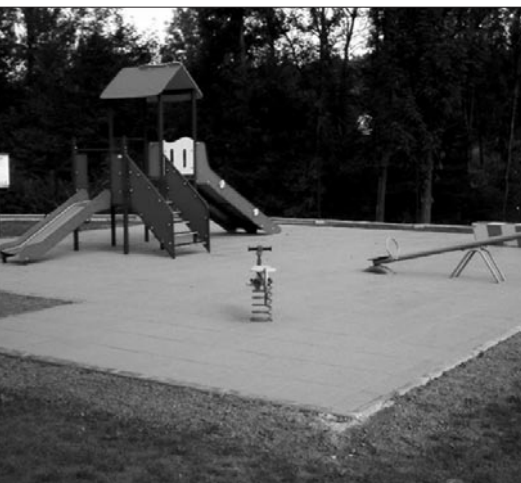
Prace przy Szkole Podstawowej w Olszance
