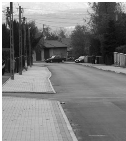
Przebudowy Dróg Lokalnych
