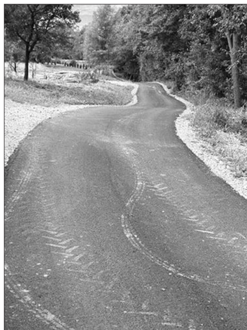
Droga gminna Pod Wysokim
