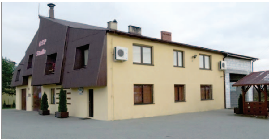
Rozbudowa i nadbudowa budynku remizy OSP
