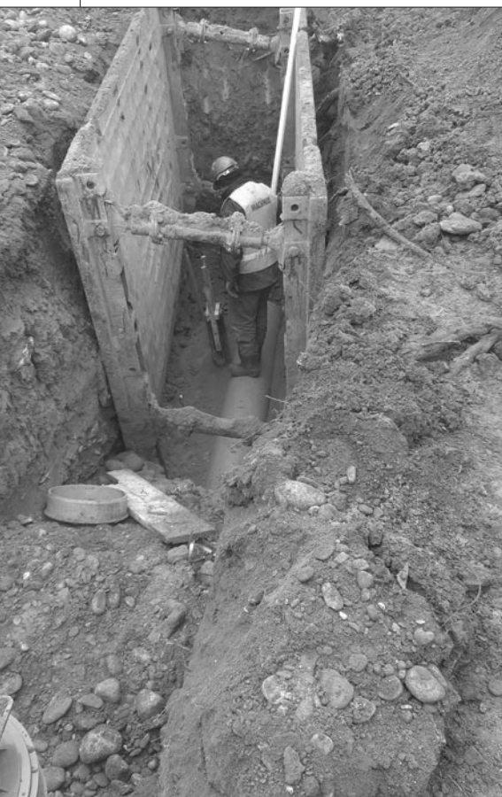
Stadła – Budowa kanalizacji
