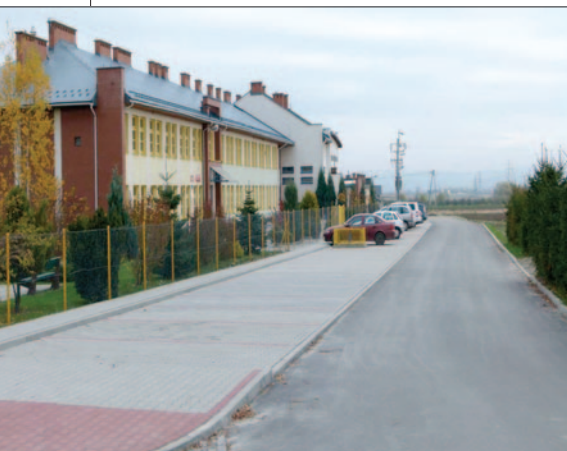
Przebudowa centrum wsi Brzezna
