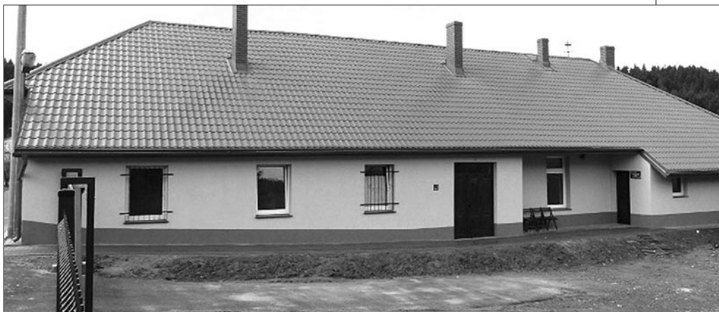
Remont filii GOK w Naszacowicach
