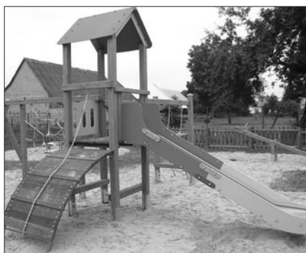
Stadła – budowa placu zabaw
