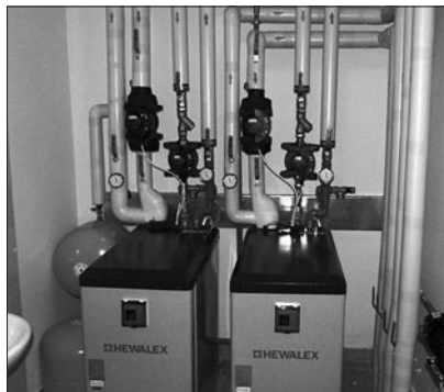
Montaż pomp ciepła
