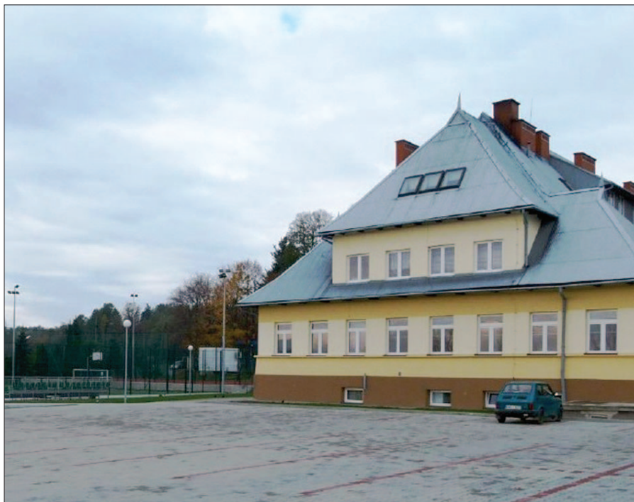
Przebudowa centrum wsi Brzezna
