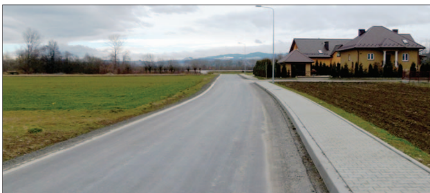
Stadła – przebudowa drogi Remiza-Barczynki
