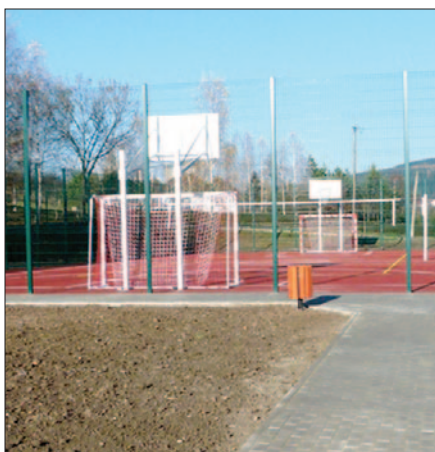
Budowa boiska wielofunkcyjnego
