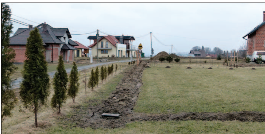
Rozbudowa kanalizacji sanitarnej w Brzeznej
