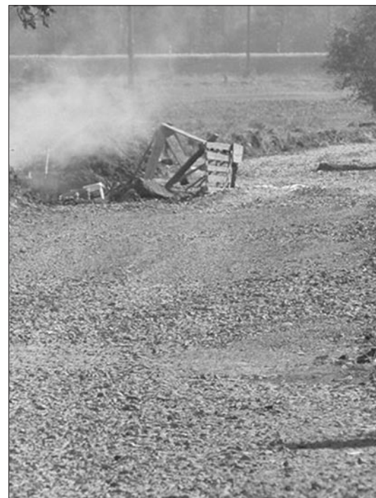
Przebudowa drogi gminnej WYGON
