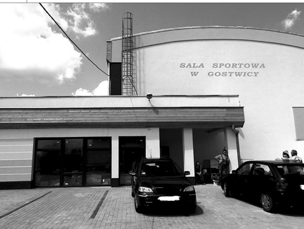
Budowa sali gimnastycznej w Gostwicy
