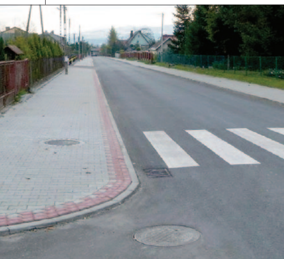
Przebudowa centrum wsi Brzezna
