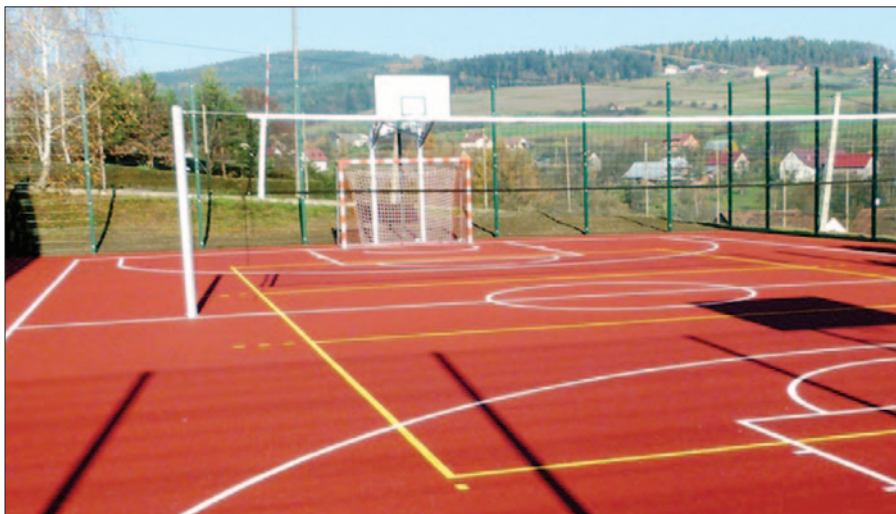
Budowa boiska wielofunkcyjnego
