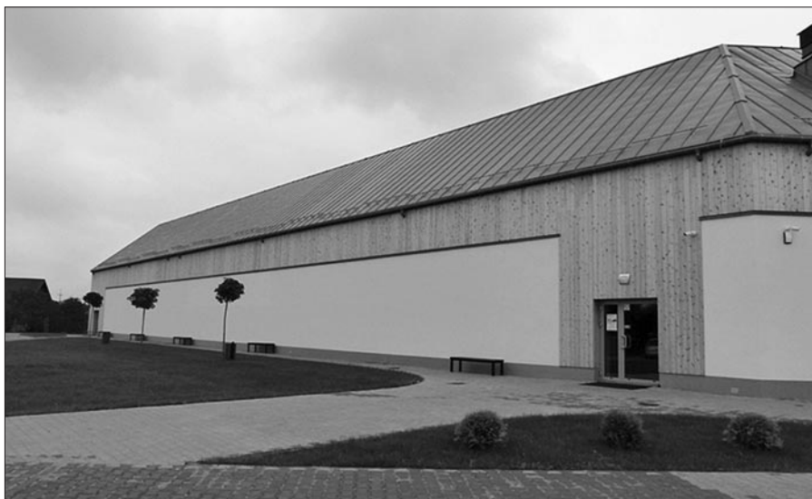
Budowa Biblioteki Gminnej w Podegrodziu
