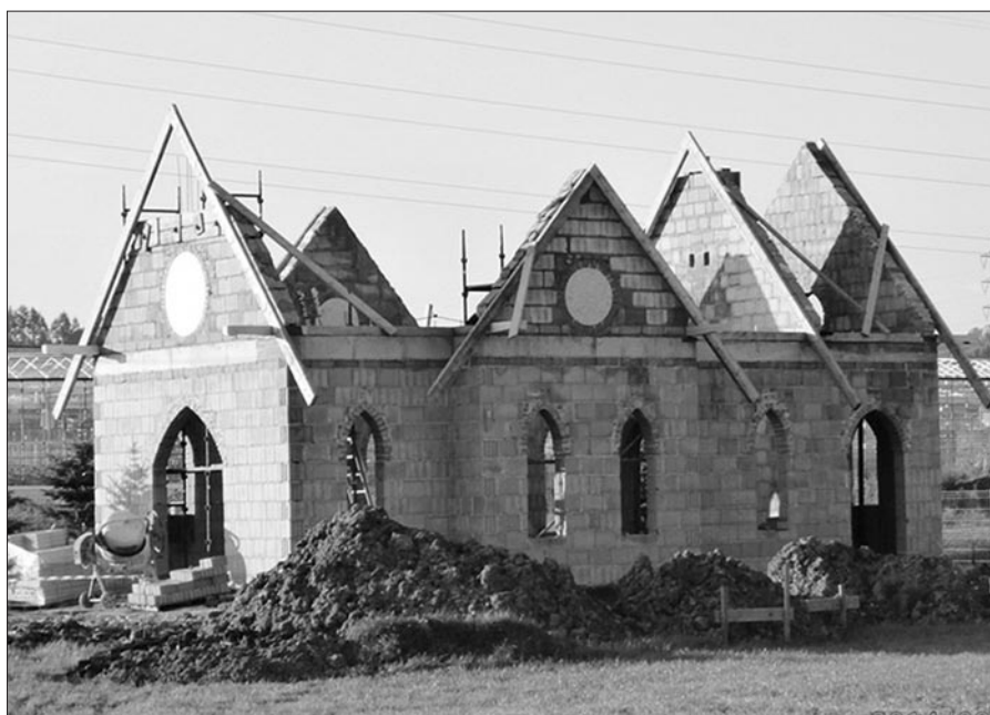
Budowa kaplicy cmentarnej
